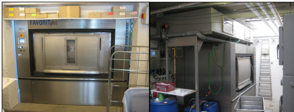
Austausch einer alten Waschschleudermaschine mit Wasserrückgewinnung
